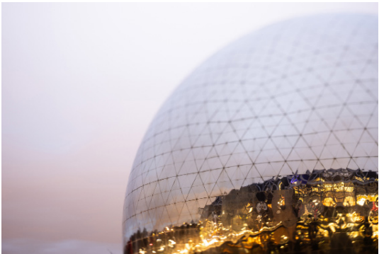
Après six ans de travaux, La Géode a rouvert en décembre 2024, avec un écran Imax Laser 4K unique en France.
